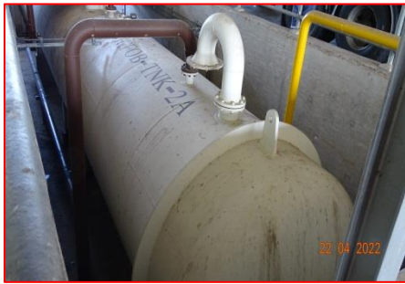
ภาพที่ 2.2-1 ถังเก็บน้ำมันใต้ดิน
