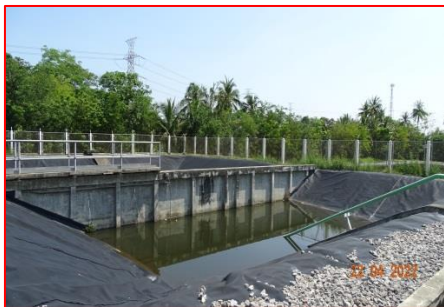
ภาพที่ 2.2-8 บ่อน้ำทิ้งที่ผ่านการบำบัดจาก Oil Separator และบ่อ Holding Pond
