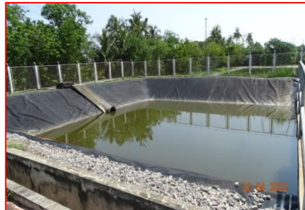
ภาพที่ 2.2-8 บ่อน้ำทิ้งที่ผ่านการบำบัดจาก Oil Separator และบ่อ Holding Pond
